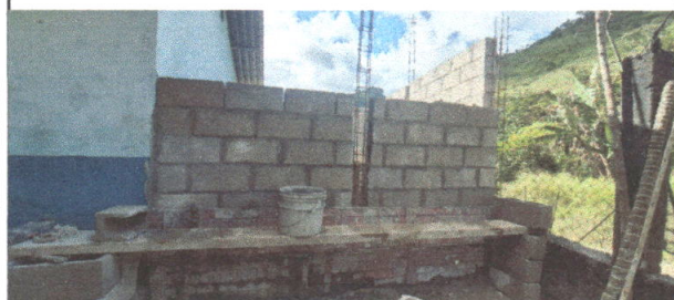
Foto 1: REMODELACION Y AMPLIACION DE COCINA
