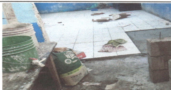
Foto 5: Sustitucion de piso de cemento a azulejo en la cocina.
