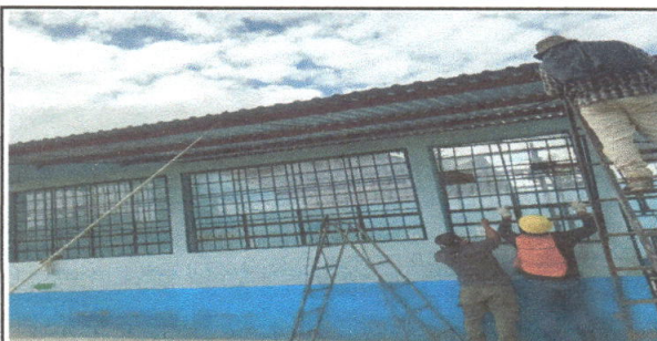
Foto 6: COLOCACION DE BALCONES EN MODULO 3.
