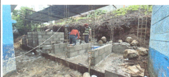
Foto 2: REMODELACION Y AMPLIACION DE BAÑOS
