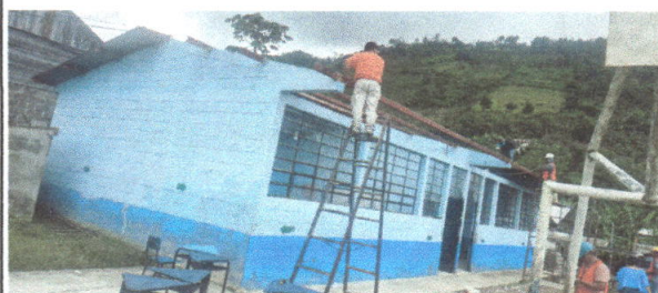
Foto 4: CAMBIO DE LAMINA NORMAL A LAMINA TROQUELADA
